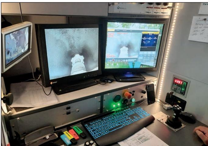
Auch in diesem Jahr finden Arbeiten zur Erneuerung der in die Jahre gekommenen Abwasserleitungen statt. Auf den Bildern ist der Steuerstand eines Facharbeiters zu sehen. An mehreren Bildschirmen bedient er einen Fräsroboter, der Risse in den Betonrohren aufraut, um diese anschließend mit flüssigem Kunstharz abzudichten. In einem weiteren Abschnitt der Betzenweiler Straße wird ein stark beschädigter Teil der Leitung saniert. Dort wird ein sogenannter Inliner eingebracht – vereinfacht gesagt
